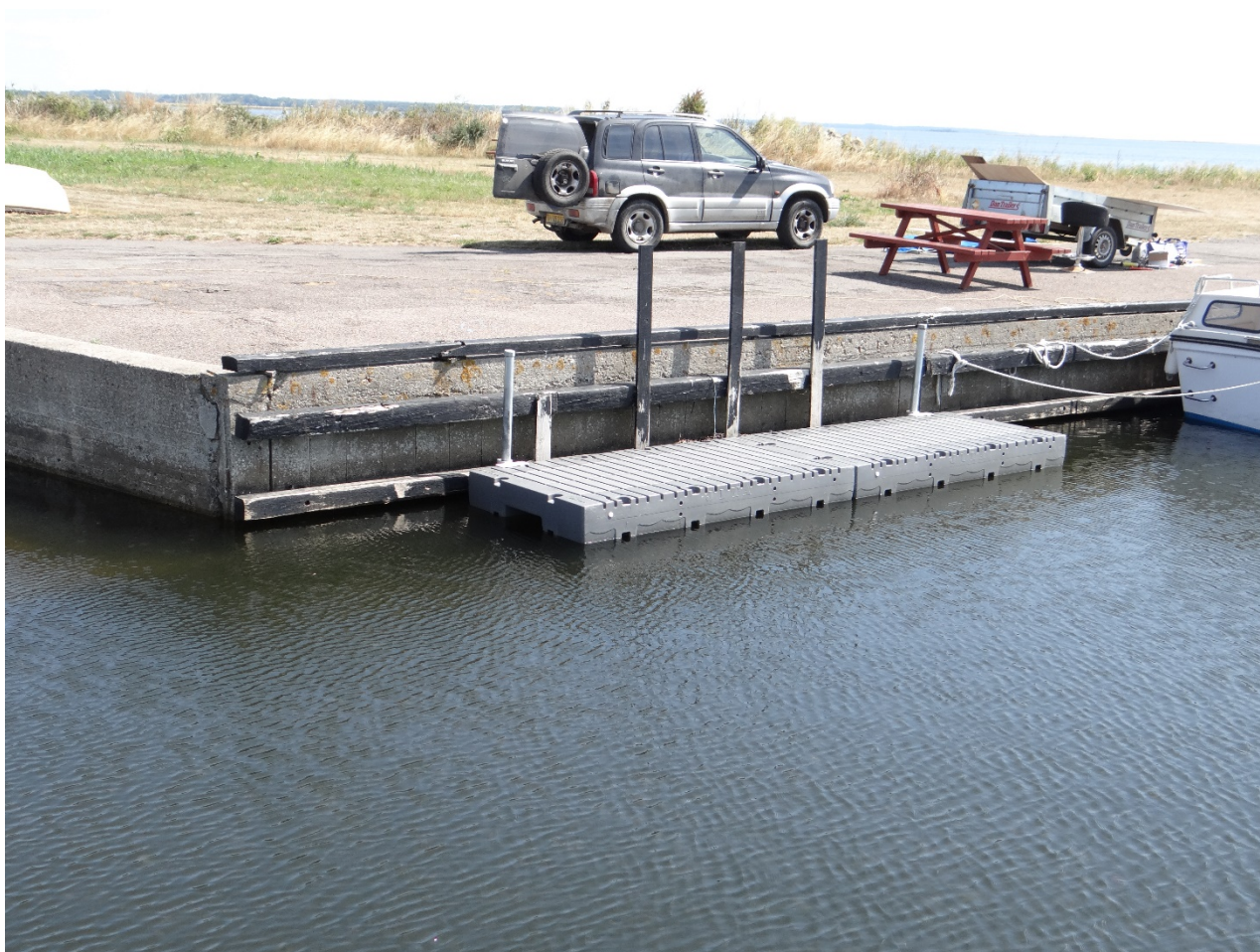
Støbt plastflydebro i Errindlev havn – opsat i forbindelse med Naturlandet – Broen skiller sig her ikke markant ud fra det eksisterende miljø.
