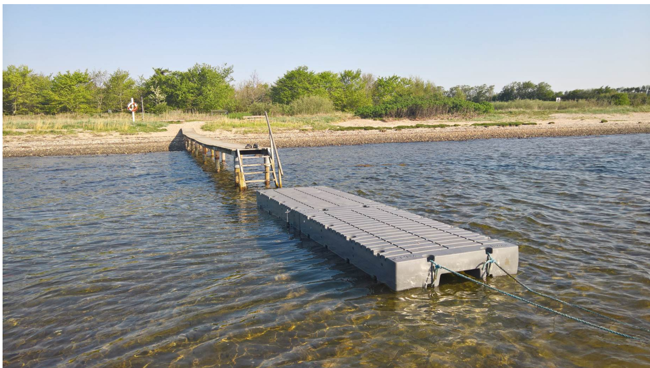
Plast flydebro i forlængelse af klassisk træbro, plastbroen fremstår markant og fremmede i det åbne kystlandskab, men vil her være mindre dominerende fra kysten
