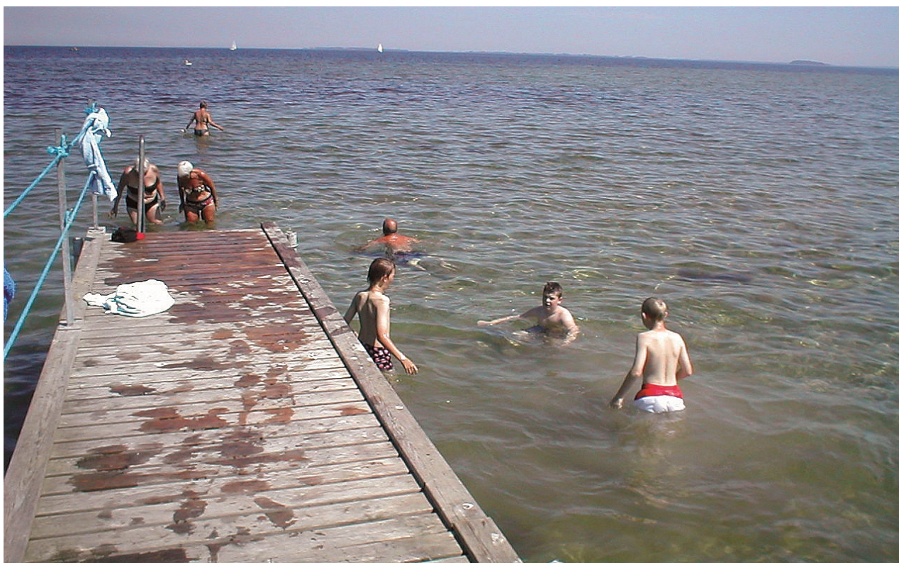
Fast træ/stål bro i Kragenæs med simpelt rækværk
